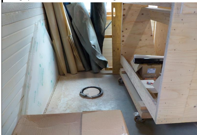
Photographie de la localisation de l'ouvrage
