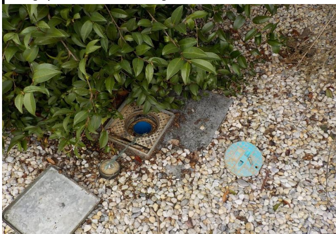
Photographie de la tête de l'ouvrage
