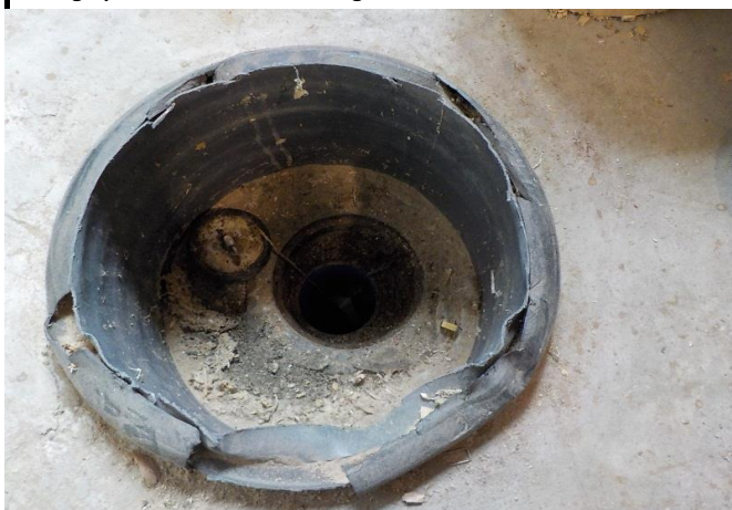
Photographie de la tête de l'ouvrage
